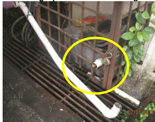
Gambar 1.14 Perangkap Lemak Tidak Berfungsi
